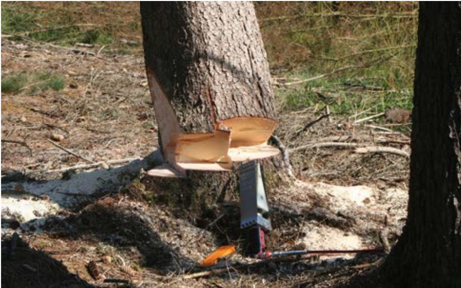
Abb. 2: Sichere Fällung mittels Fällkeil per Fernauslösung
