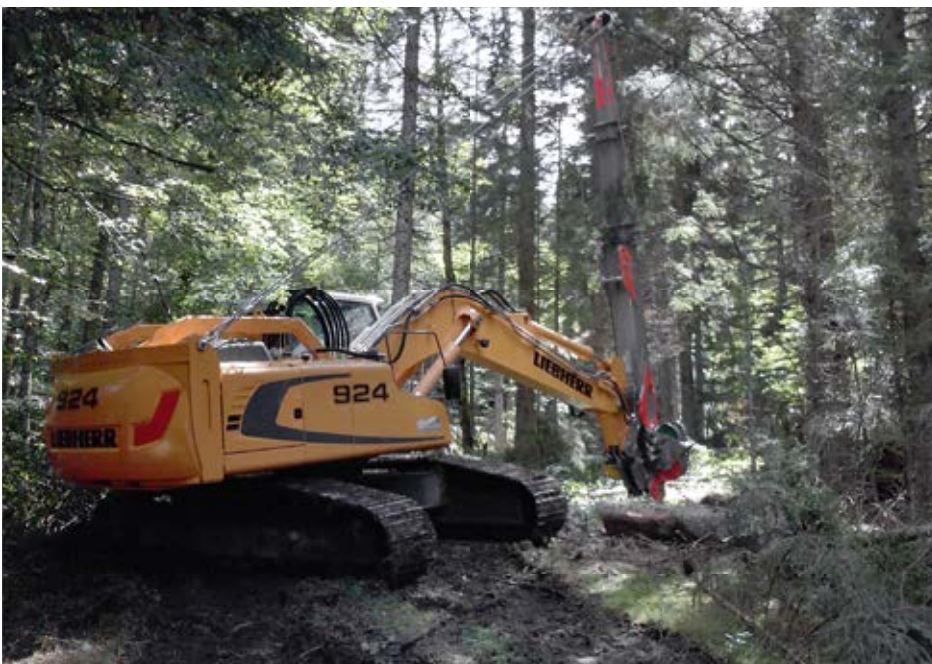
Einsatz des Endmastbaggers als Endbaustütze.
